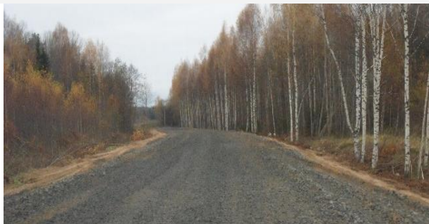
Участок автомобильной дороги Коняево - Простино
